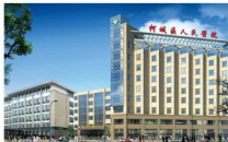
浙江绍兴柯桥人民医院
